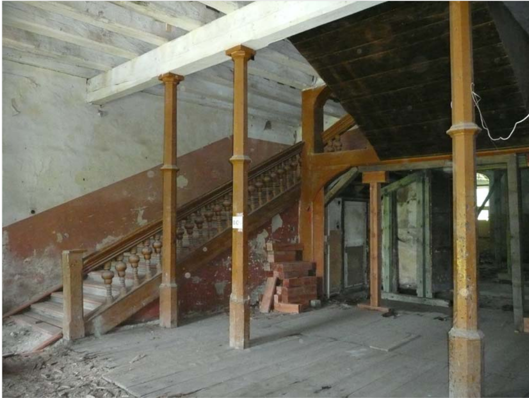
Bild 3a Treppenhaus EG im heutigen Zustand. Der Einbau der zusätzlichen Stützen erfolgte 1850 aufgrund großer Durchbiegungen der Decke
