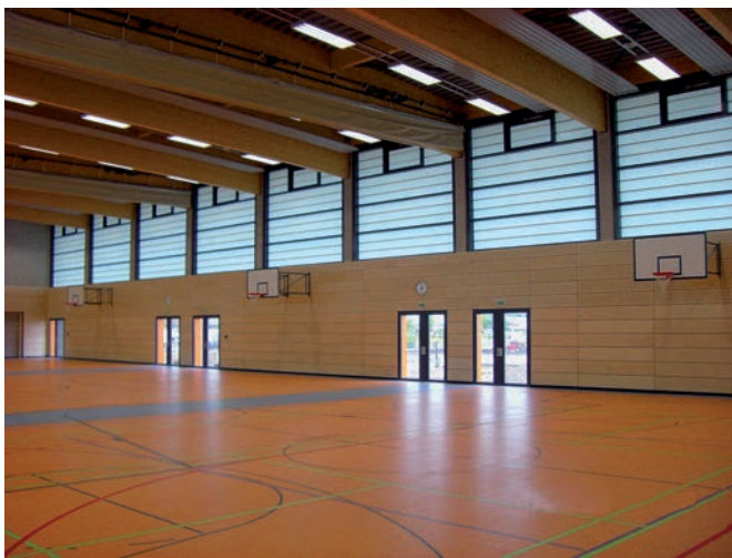
Bild 1 Sporthalle Oberstufenzentrum Nauen 2007: Die Brandlast wird im Wesentlichen von der hölzernen Prallwand und dem Fußbodenaufbau sowie den Fiberglas-Fassadenelementen gebildet Gymnasium Oberstufenzentrum Nauen 2007. The fire load is essentially formed on the wooden baffle and the floor structure and the fiberglass elements
