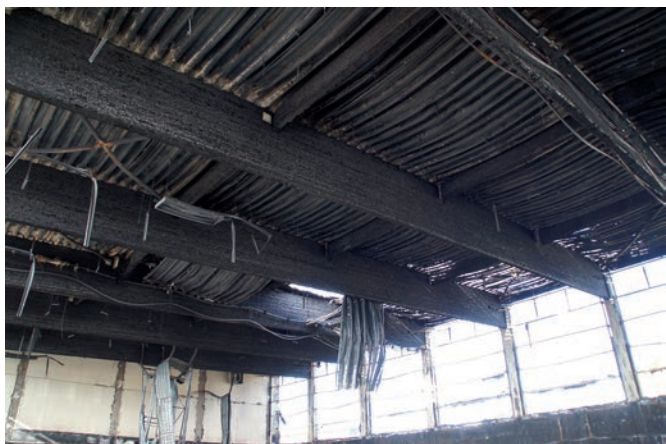
Bild 3 Innenansicht nach dem Vollbrand: Die Brettschichtbinder verblieben in ihrer Position, die Holzpfetten sind teilweise herabgefallen, die Dacheindeckung aus Stahltrapezprofilen ist bereichsweise durchgebrannt, an den Giebelwandstützen sind deutliche Betonabplatzungen auf ganzer Bauteilhöhe erkennbar
