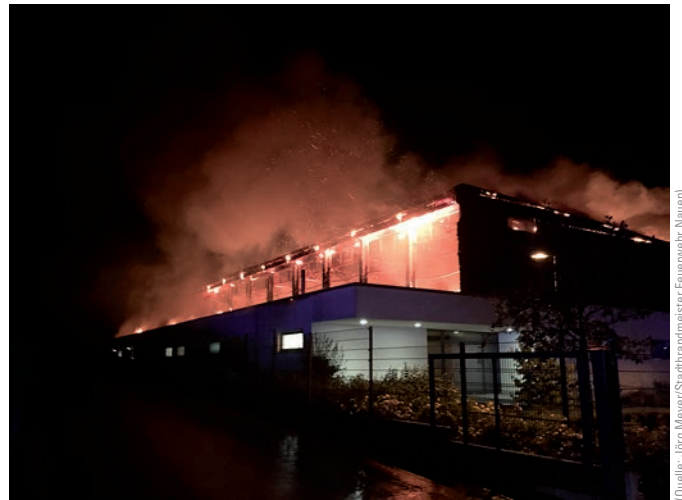
Bild 2 Entwickelter Vollbrand der Sporthalle Nauen zum Zeitpunkt des Eintreffens der Feuerwehr um 2.39 Uhr: Die Fassadenelemente des Fensterbands sind hier bereits komplett abgebrannt; vorn im Bild der Sozialtrakt mit den Umkleideräumen Expanded fire of the gym in Nauen at the time of arrival of the fire department at 02.39AM. The façade elements near the windows are completely burned in the front you can see the social tract with the changing rooms
