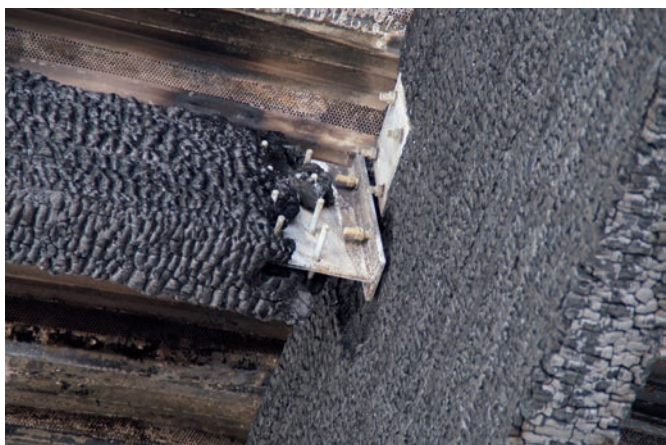
Bild 4 Die Anschlussbereiche der Pfetten an die Brettschichtbinder sind zum Teil komplett durchgebrannt, der geschlitzte Holzquerschnitt mit dem innen liegenden Stahlblech und den Stabdübeln war der brandschutztechnische Schwachpunkt der tragenden Konstruktion
